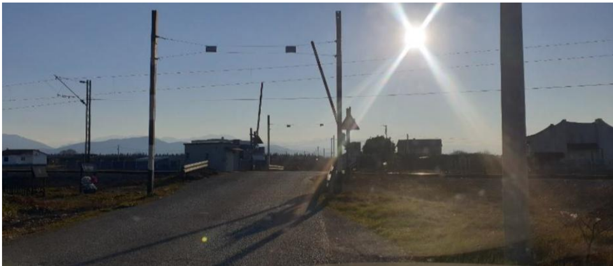
Slika 3 Željeznički putni prelaz Vukovci
